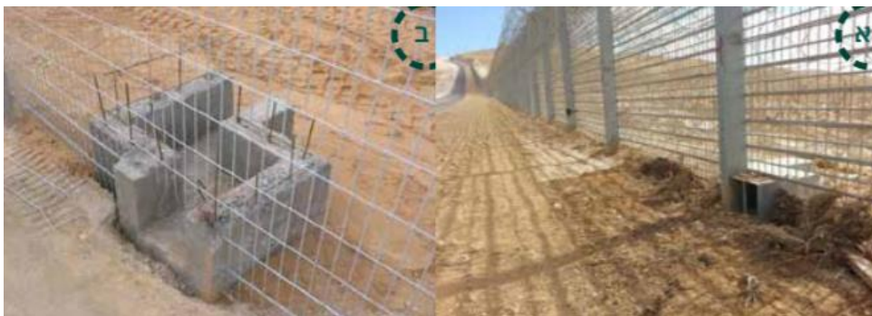
תמונה 4 א, ב. דוגמא לשילוב מעבר 'ל' בגדר גבול ישראל-מצריים המאפשר מעבר יונקים קטנים ובינוניים, זוחלים ופרוקי רגליים (דחת וחובריו 2015).
